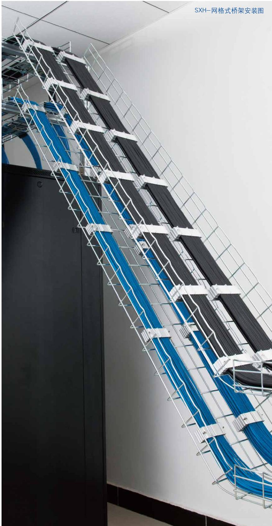
SXH-网格式桥架安装图
