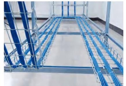
SXH-网格式桥架安装图5
