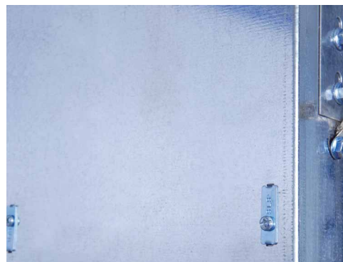
桥架盖板固定方式
