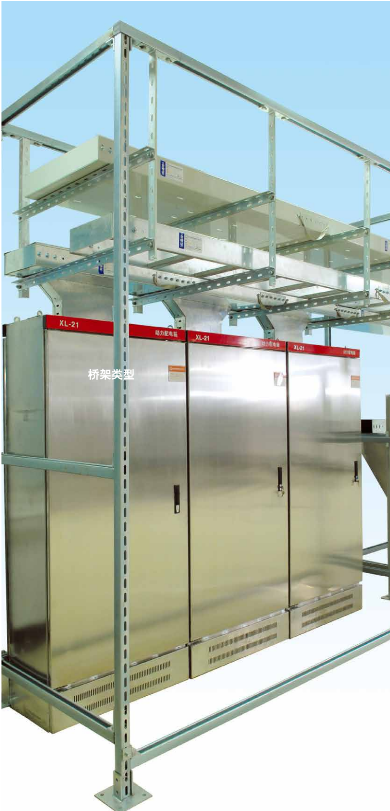
电缆桥架安装图1
